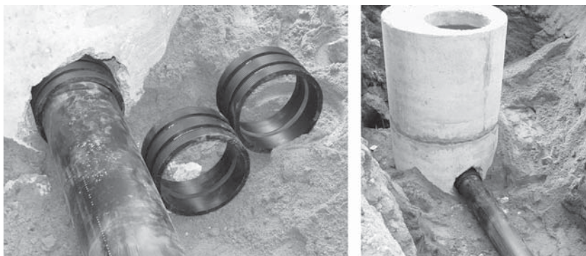
Фото 2.1. Защитные муфты для входа в бетонный колодец
